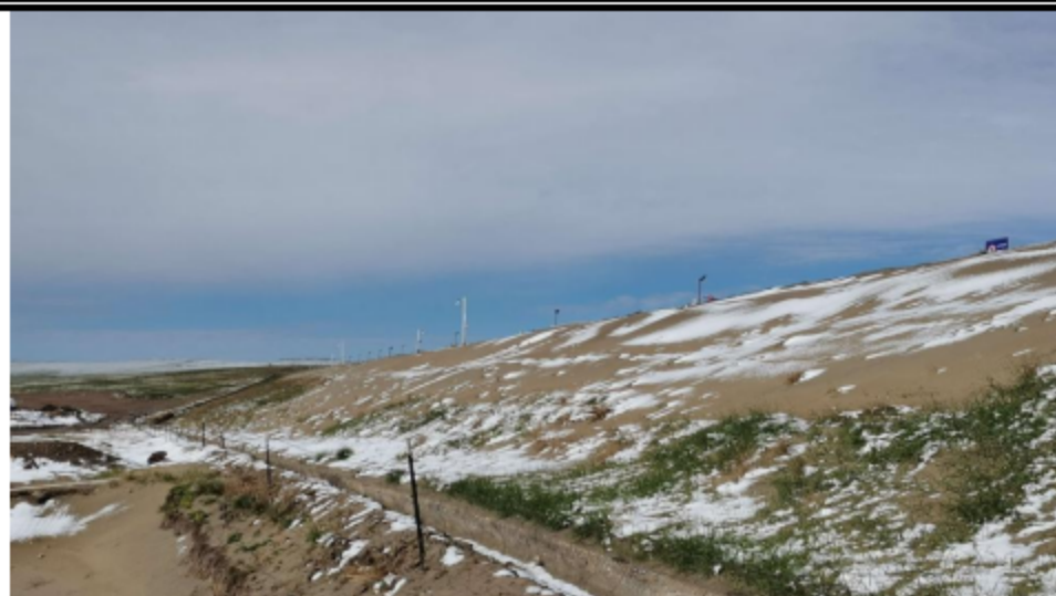
尾矿库初期坝
