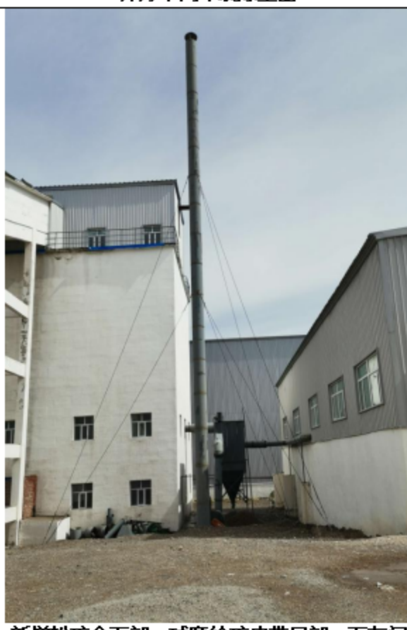
新增粉矿仓下部、球磨给矿皮带尾部、石灰间 布袋除尘器
