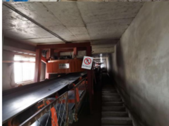
破碎全封闭皮带廊道
